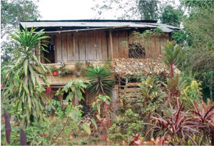
Figura 2. Características de una casa y su peridomicilio, de la zona de Nuevo Zapotal. No todas las construcciones tienen el cerramiento inferior.
