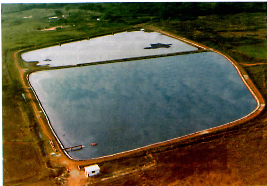
Fig. 1. Vista aérea das lagoas de estabilização de esgoto de Inhumas
