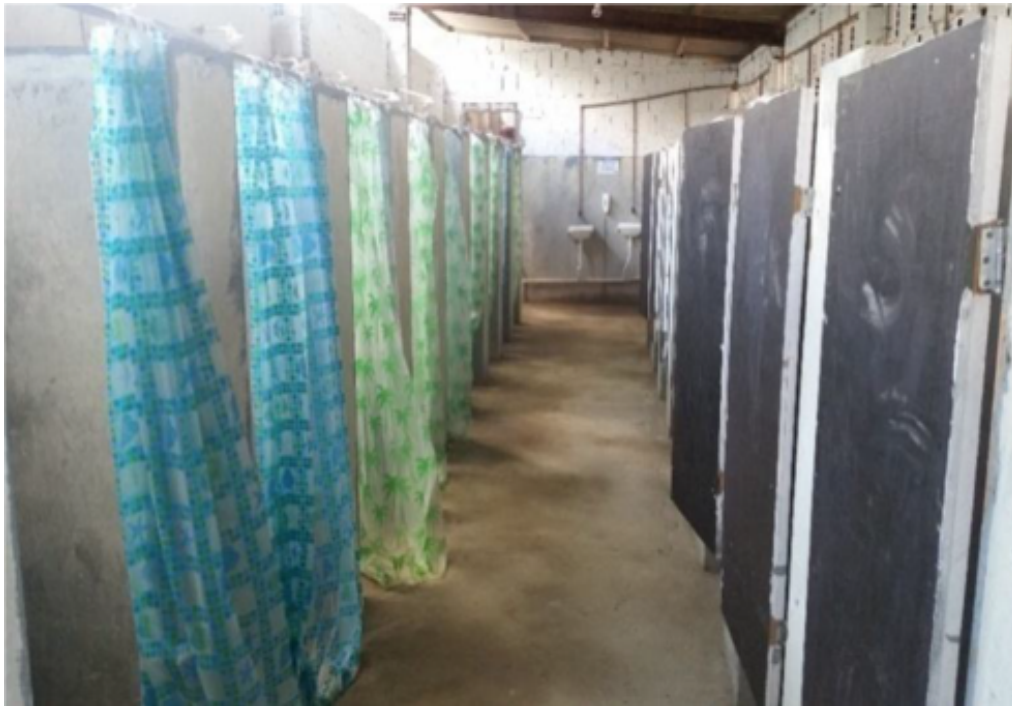
Fotografia 2. Banheiro conforme regulamenta a NR 18.
