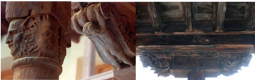
Figura 2.- Detalles decorativos en elementos lignarios. Autor. M.L. Gutiérrez Carrillo
