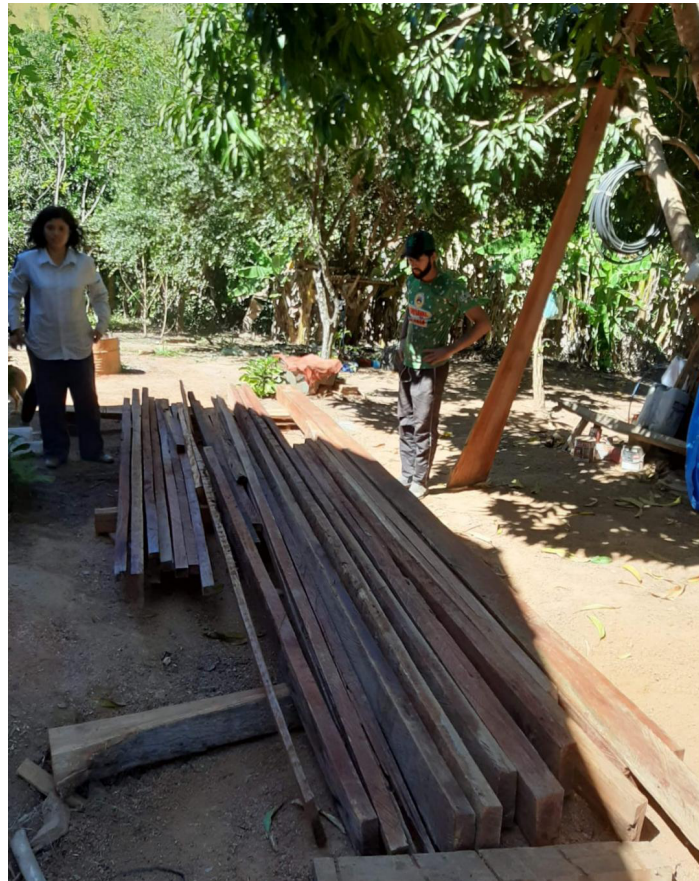
Figura 5 - As vigotas e caibros para área. Fazenda córrego do Palmito
