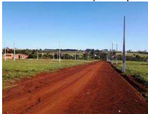
Figura 12- Loteamento em construção Canápolis-MG.
