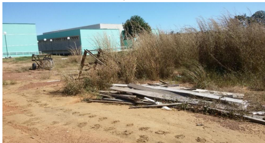
Figura 5 - Deposição inadequada de Resíduos de Construção civil, câmpus da UFT – Gurupi, TO
