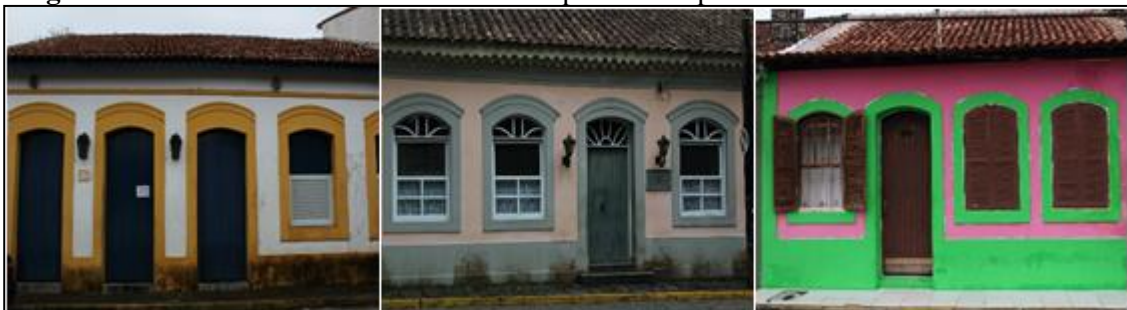
Figura 8 - Casas em estilo colonial tombadas pelo Condephaat em Cananeia
