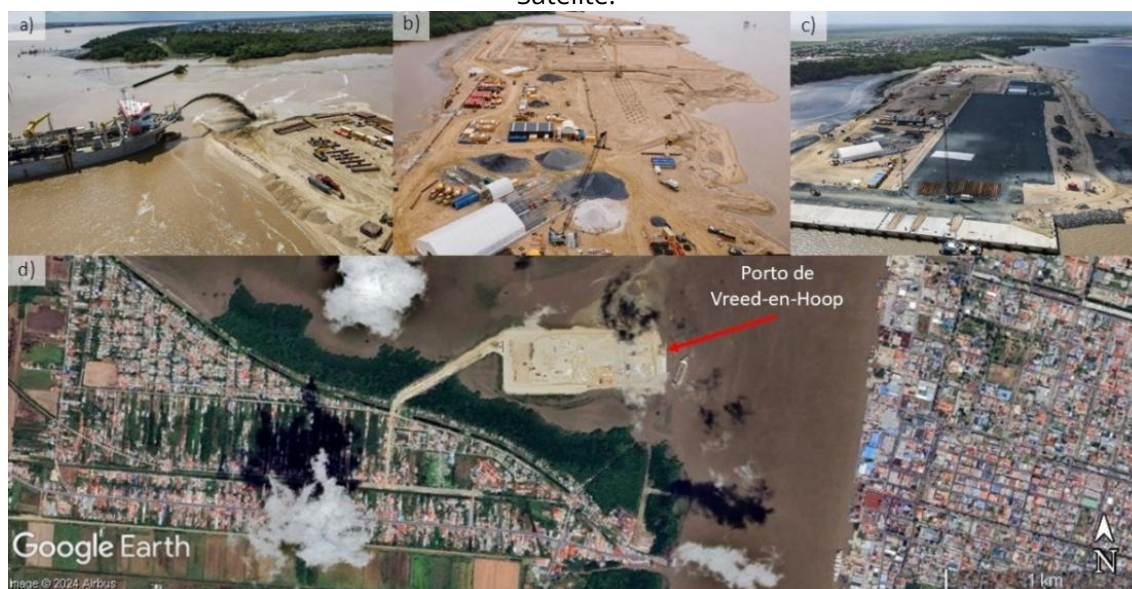
Figura 6: Porto de Vreed-en-Hoop na Guiana: a) dragagem e aterro; b) área aterrada; c) área aterrada com construções sendo realizadas; d) área do aterro vista por imagem de Satélite.
