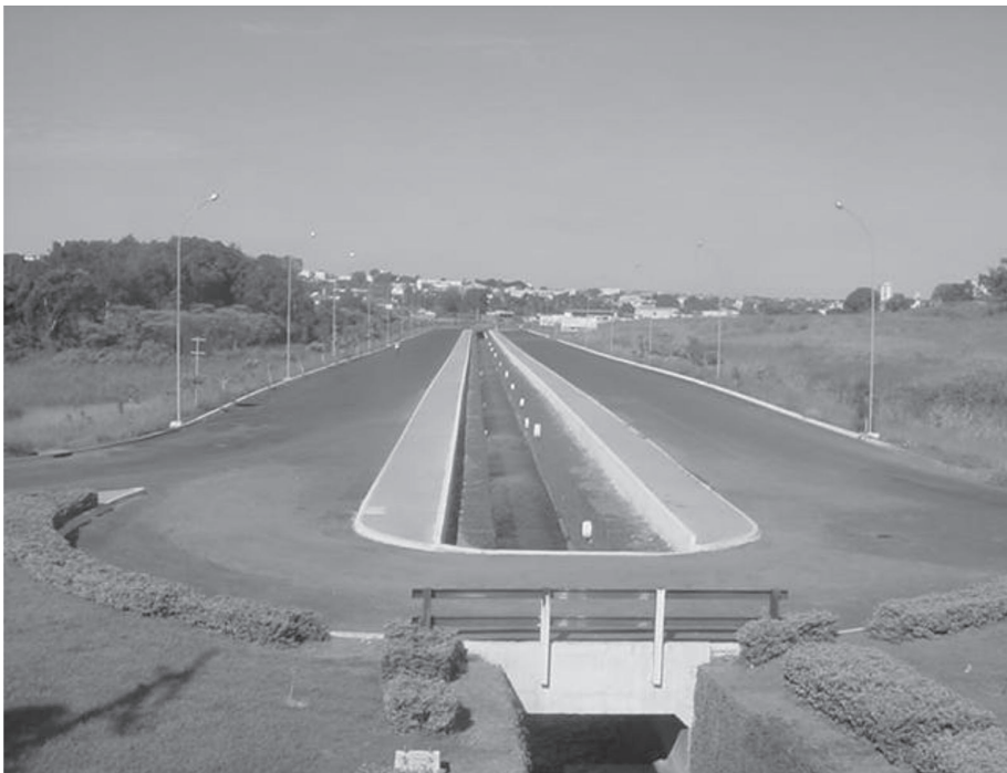
Figura 4: Vista panorâmica de um trecho canalizado do Ribeirão Pirapitinga.
