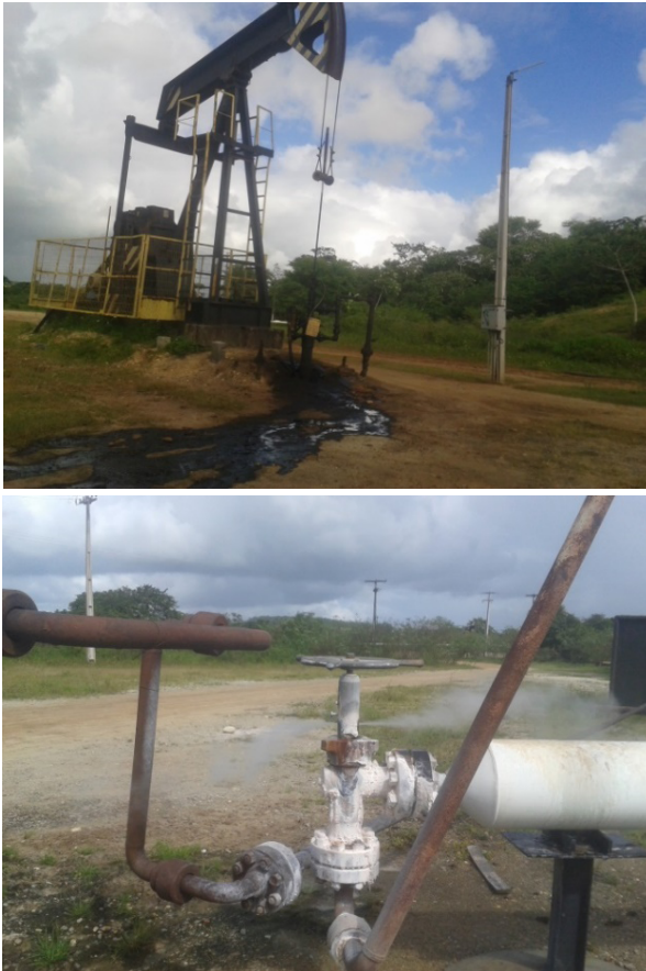
Figura 3 - Vazamento de óleo e gás no município de Carmópolis, junho/2014
