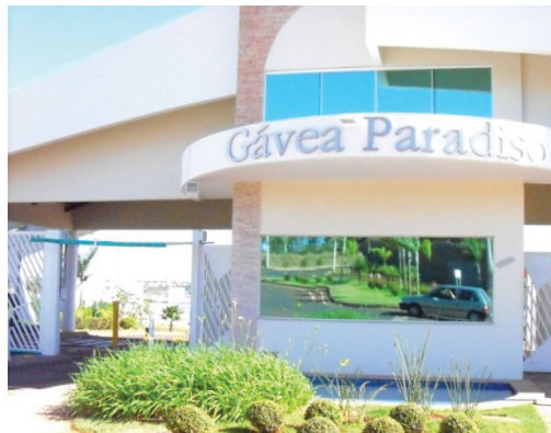
Figura 8 - Portaria do Condomínio Gávea Paradiso
