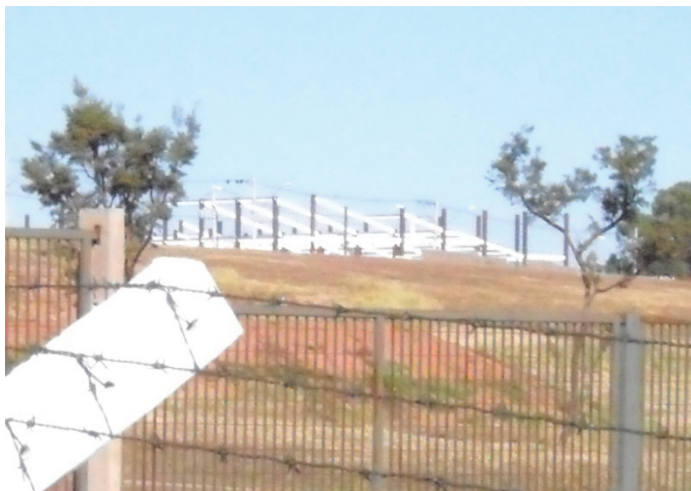
Figura 5 - Obras do Uberlândia Shopping
