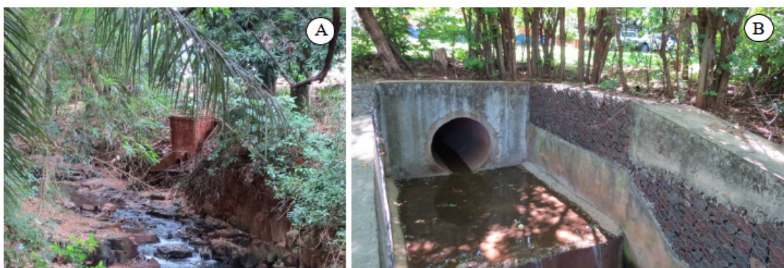
Figura 11. Exutório de córregos enterrados na bacia hidrográfica do córrego Sóter, Campo Grande/MS.
