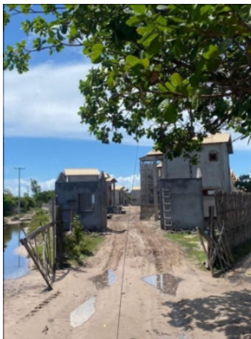
Figura 3 - Construção do condomínio Village do Una Atins (Comunidade de Santo Inácio)
