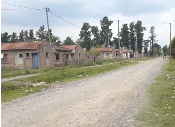
Figura 2: Viviendas de la comunidad Nam Qom. Fuente: Registro propio, 2014.
