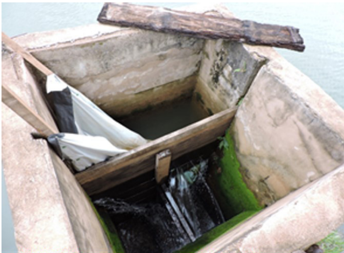
Figura 6: Estrutura de concreto conhecida por “monge” em represa no Alto São Marcos com tábuas que controlam a vazão
