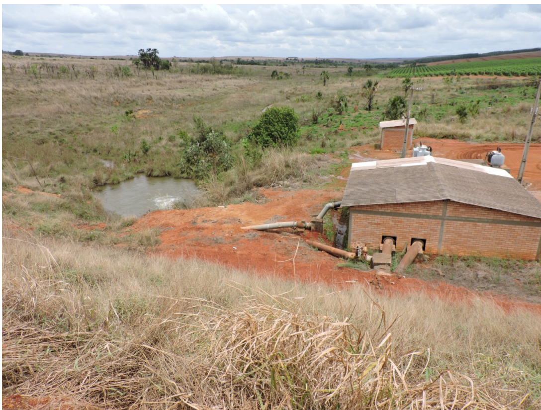
Figura 5: Casa de máquinas e sistema de captação e descarga de fundo em propriedade rural no Alto São Marcos
