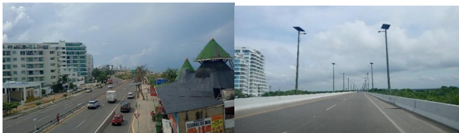
Figura 3: La Boquilla - Viaducto Gran Manglar. Fonte: Trabalho de campo, novembro de 2021.
