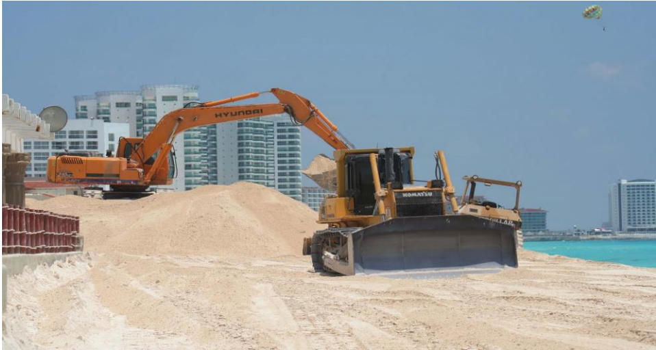
Figura 4: Tendido de arena en la zona hotelera de Cancún Fuente: Caballero, 2009a
