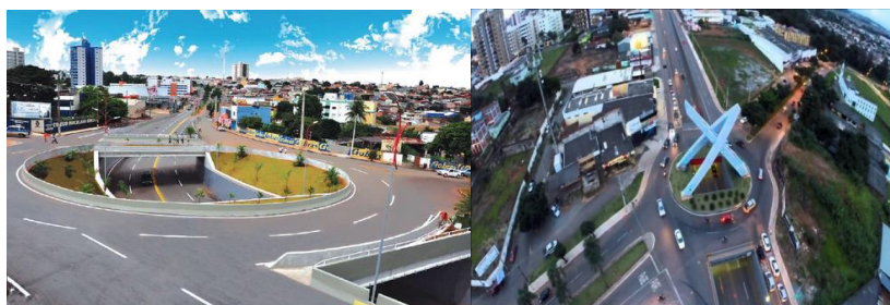
Figura 6: a) Trincheira no encontro de avenidas; b) Viaduto Nelson Mandela Fonte: Diário Anápolis (2011) e JR Vídeos (2017).
