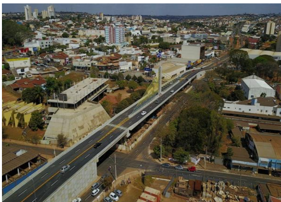
Figura 7: Elevado Avenida Brasil Fonte: Rusta Cardoso, 2017.
