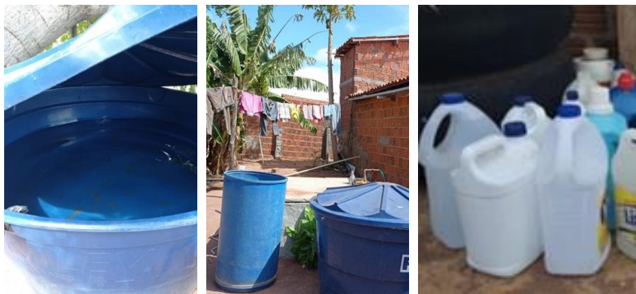
Figura 5: Reservatórios com armazenamento de água pluvial
