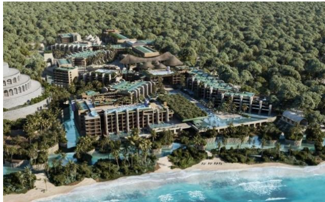
Figura 2: Xcaret Arte Hotel Fonte: Sentido común (2021)
