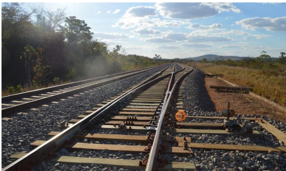
Figura 9. Área destinada à construção do Pátio de Santa Isabel da FNS. Foto: Os autores (2018).
