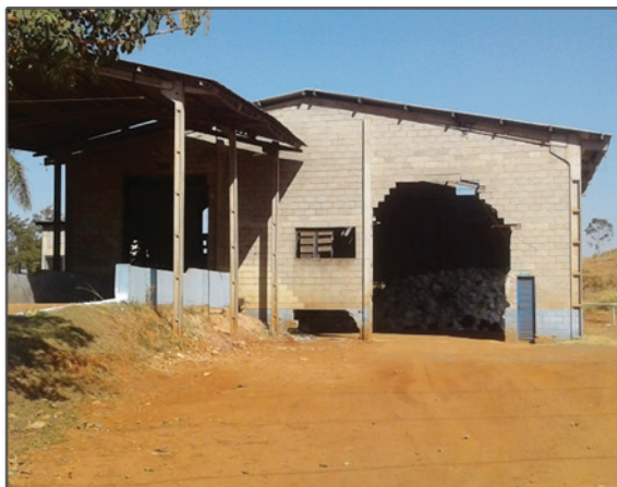
Figura 9. Galpão onde são condicionados os RSS. Fonte: Autor,2016.
