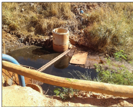
Figura 6. Lançamento de chorume em local Inadequado.
