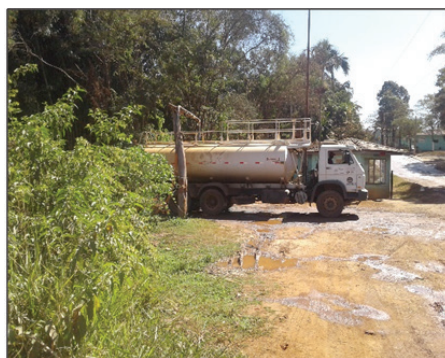
Figura 4. Caminhão captando água para aspergir no aterro. Fonte: Autor, 2015.
