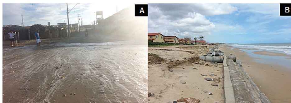
Figura 7. Espraio máximo das ondas atingindo a frente marinha urbana do Icaraí (A); Infraestruturas urbanas atingidas durante as ressacas do mar em janeiro/14 (B).
