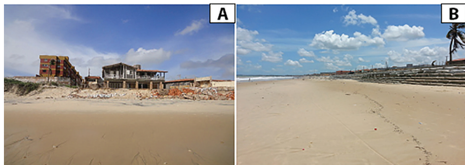
Figura 2. A) Destruição de faixas frontais de muros condominiais localizados na alta praia; B) Estrutura de concreto do tipo Bagwall construída, em 2011, para atenuar os problemas com o recuo da linha de costa.
