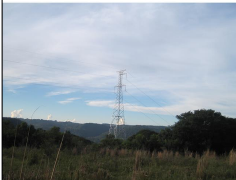
Foto nº 4: Observa-se a presença de redes de alta tensão na área do Parque do Morro.
