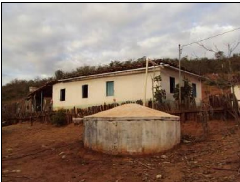
Figura 13: Cisterna construída para captação de água da chuva. Comunidade Remanescente de Quilombo de Gravatá 1, Município de Chapada do Norte, Vale do Jequitinhonha/MG – Brasil, 2009. Autor: DINIZ, R. F.
