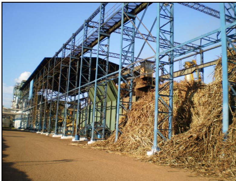
Figura 2: Local da usina em que é realizado descarregamento da cana e lavagem. Itapaci, 13 de maio de 2009. Foto: Lara C. G. Ferreira.
