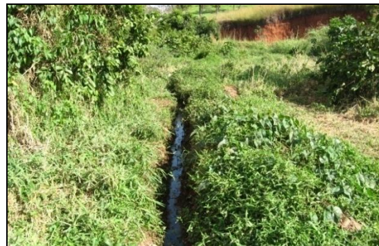
2 – Foto de lançamento irregular de esgoto no Córrego Pedreira.
